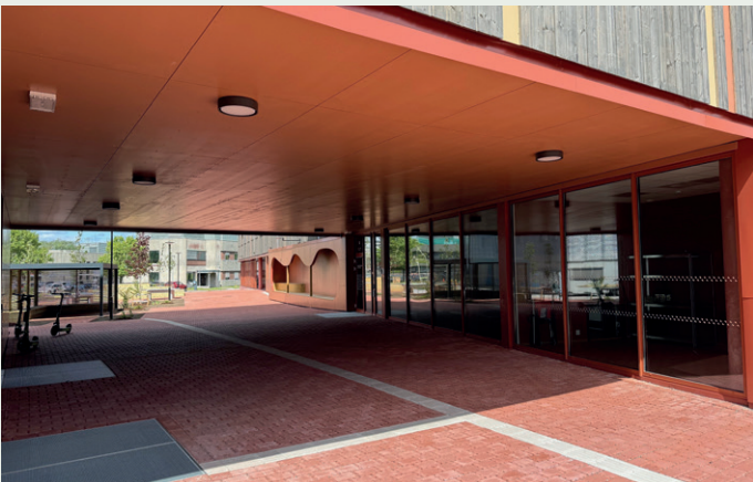
En luftig portal fører inn i gårdsrommet.
