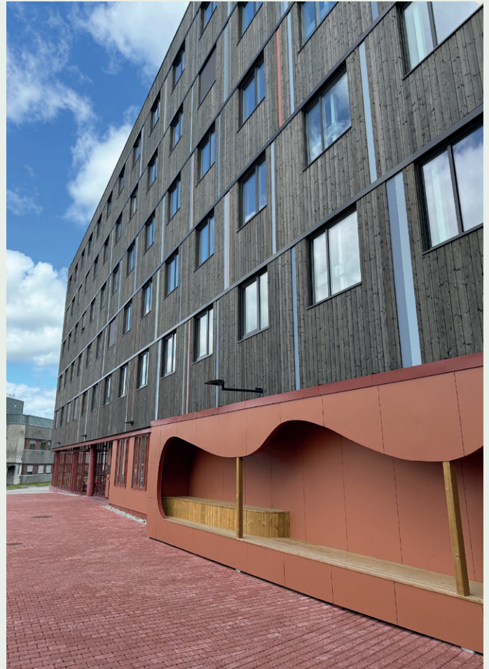
Fasaden er i hovedsak kledd med tre, og gir et solid inntrykk.
